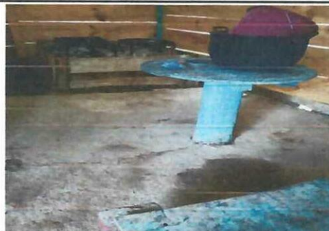
Foto 12: Reparación de piso de torta de concreto en la cocina y sustrucción de pila plástica de dos lavaderos.
