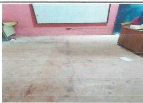
Foto 4: Sustitución de piso cerámico.
