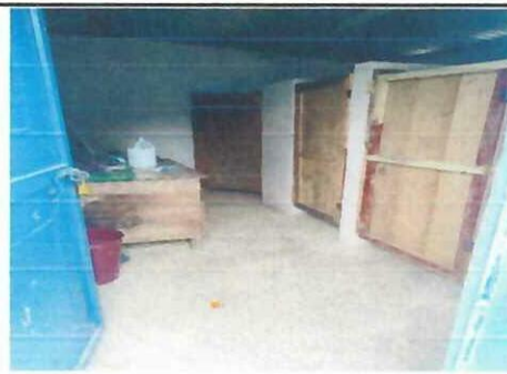
Foto 6: Sustitución de puertas de metal en sanitarios.
