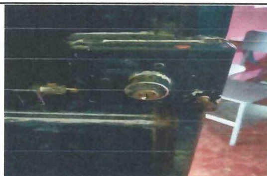
Foto 10: Sustrucción de Chapas a dos puertas de metal en aulas.
