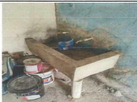
Foto 5: Intalación de azulejo en lavamanos.
