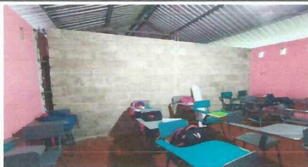
Foto1: Mejoramiento de pared de aula.
