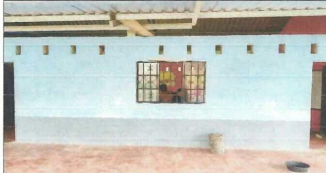
Foto 2: Sustitución de ventanas.
